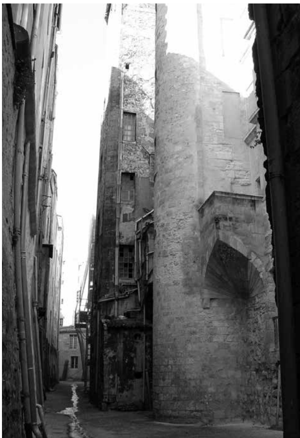
Fig. 5. - Emprise de la deuxième enceinte de Bordeaux (impasse rue Bouquière). L'étroite impasse Bouquière, à l'est de l'église Saint-Eloi, parallèle au cours Victor-Hugo, est encadrée par les deux murs de la deuxième enceinte de la ville, sur lesquels se sont greffées des constructions ultérieures. Cliché P. Régaldo, S.R.A.
