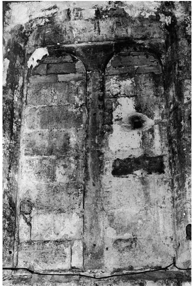
Fig. 5. Fenêtre-haute à remplage.
