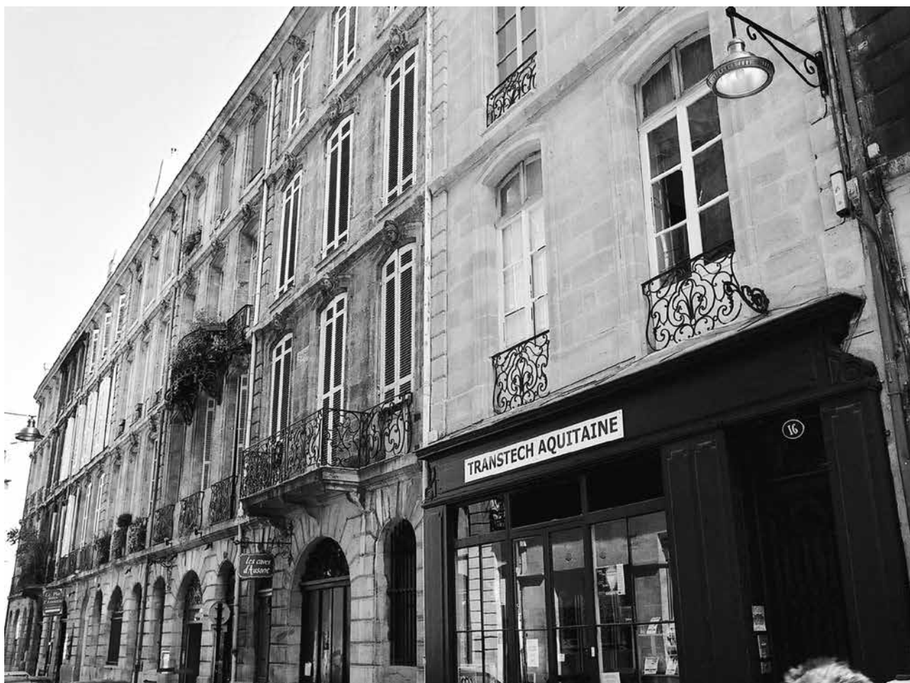
Fig. 13. - Les façades de la rue Ausone du côté pair, avec au premier plan la maison du 16 rue Ausone.
