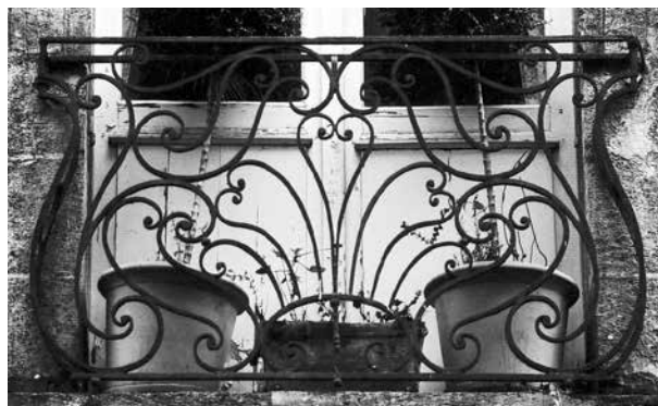
Fig. 7. - Un garde-corps de ferronnerie à la base des baies du premier étage du 10 rue Ausone.
