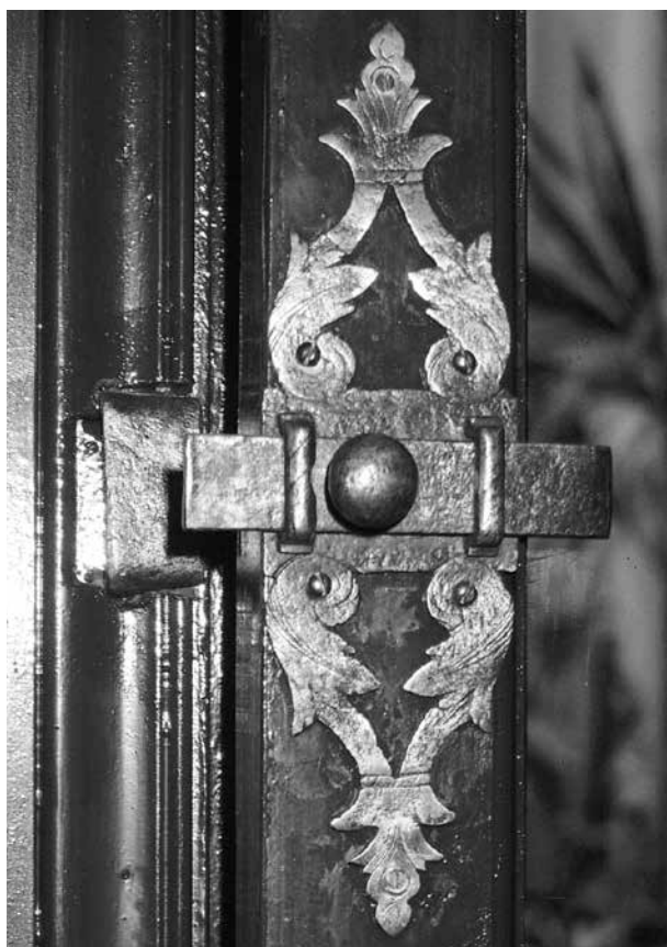
Fig. 17. - Verrou à platine de fer gravé, sans doute de Pierre Dumayne (1695)..
