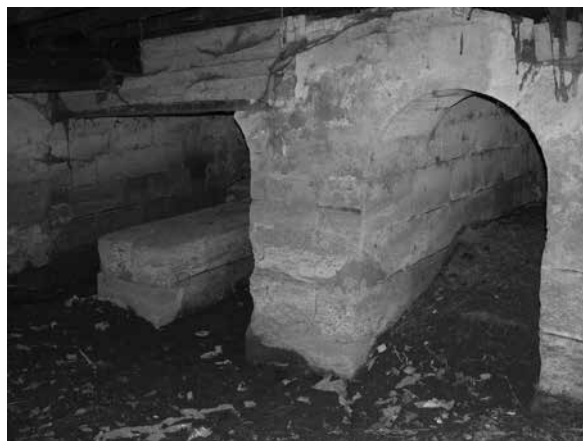
Fig. 9. – Moulin de Madères (Villenave-d'Ornon). Les pertuis d'évacuation;
