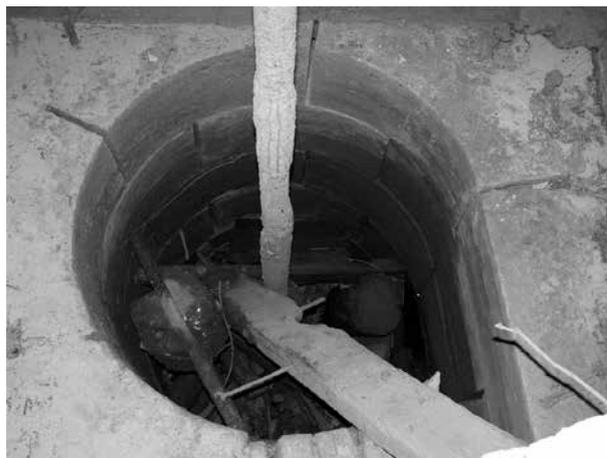
Fig. 8. - Cuve au fond de laquelle se loge la roue.
