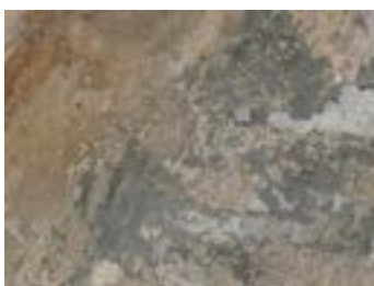
fig. 8. - Vestige d'un petit bois rayonnant peint, dans la fausse lucarne de la rue Fondaudège.
