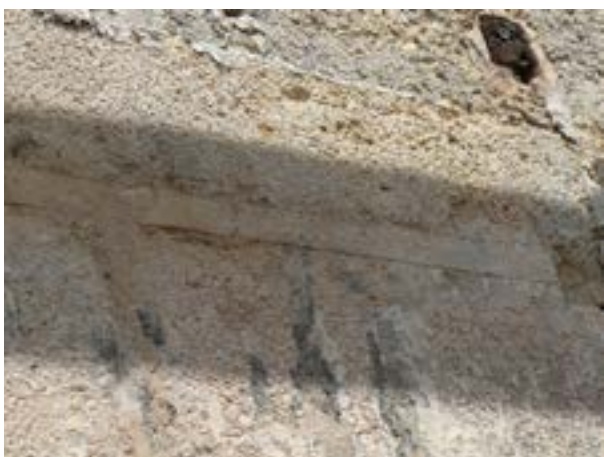
fig. 13. - Vestige d'un joint rubané sur la chaîne d'angle de la rue Fondaudège.
