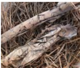
fig. 7. - Papier roulé et épis de céréale servant à l'isolation des menuiseries et des planchers.
