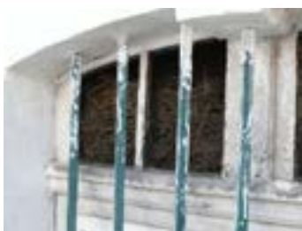
fig. 6. - Isolation du plancher à l'arrière d'un châssis de tympan, Cours de Verdun.
