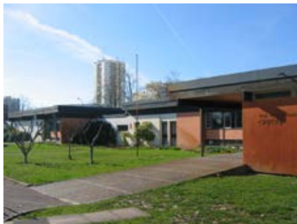
Fig. 8. - Vue extérieure partielle de la crèche-halte, février 2006.
