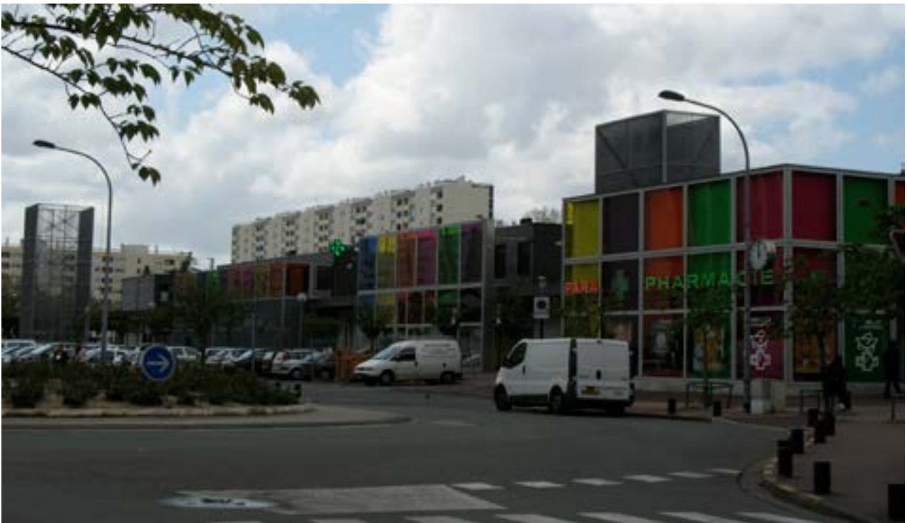
Fig. 11. - Vue extérieure partielle du centre commercial Europe rénové, avril 2008. (© Laure Perrot).
