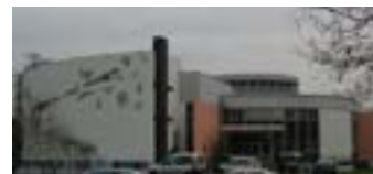
Fig. 10. - Vue extérieure partielle de la maison des jeunes, février 2006. (© A.M.Bx.).
