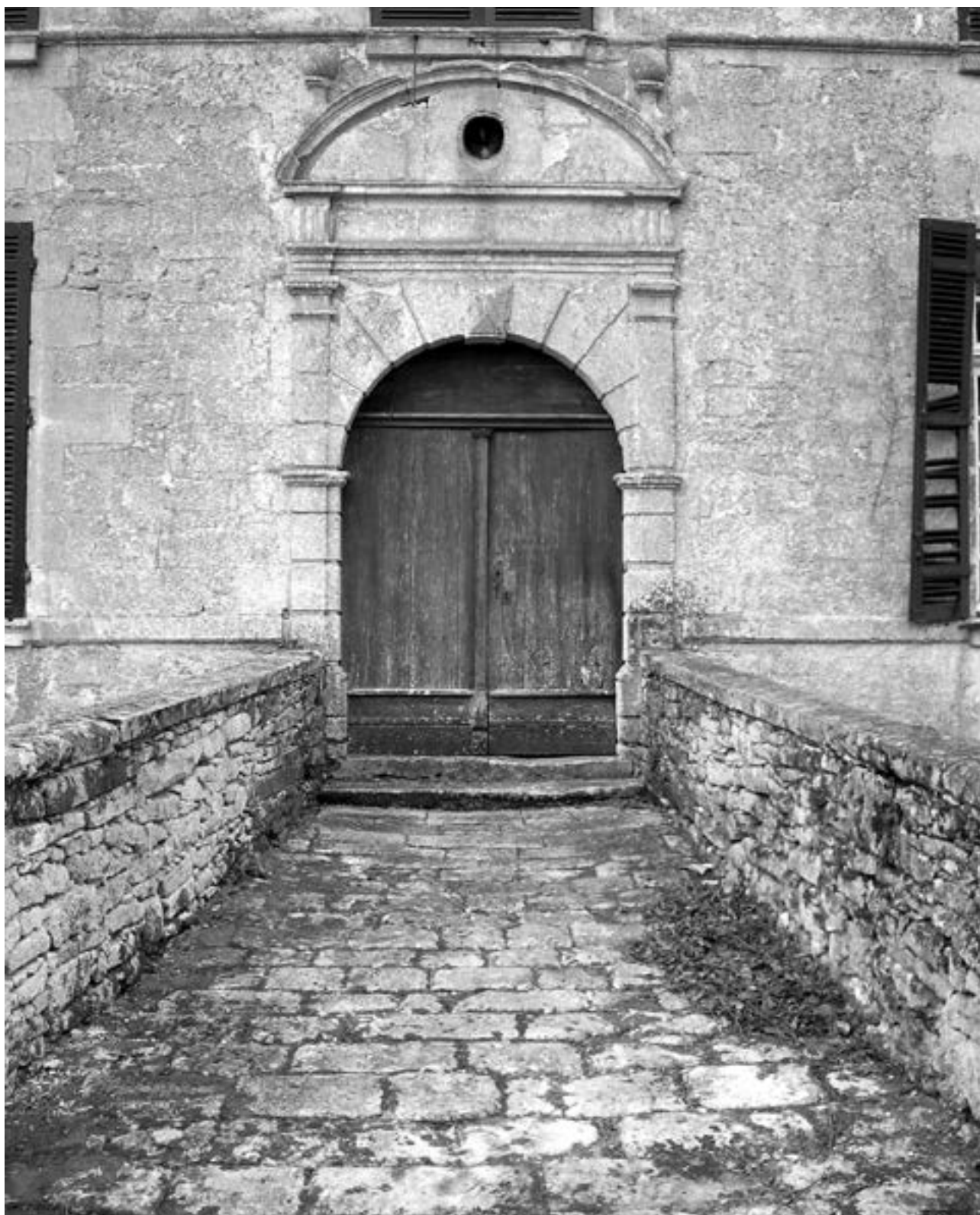
Fig. 1. - Porte du château de Vaure.
