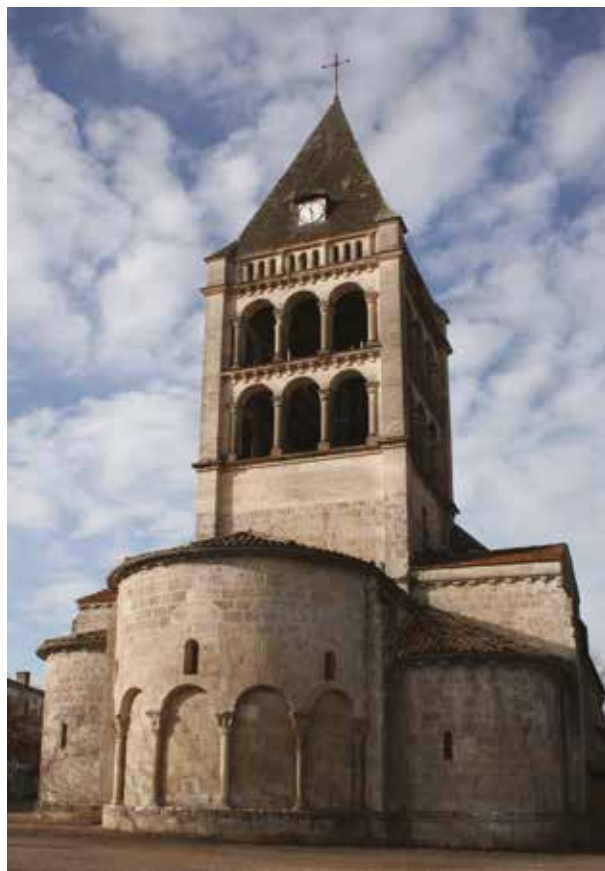
Fig. 5. - Vue du chevet depuis le nord-est.
