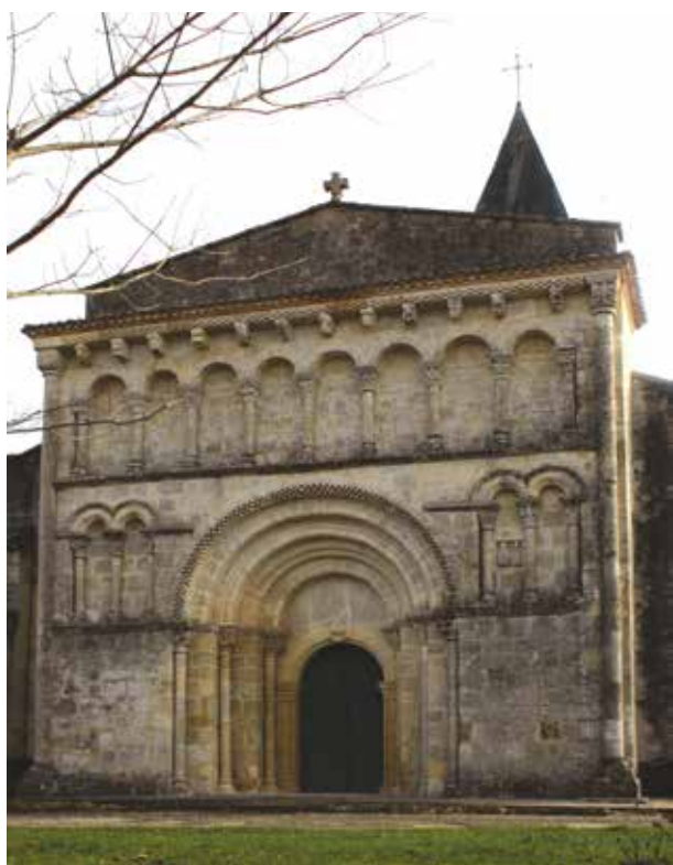
Fig. 6. - La façade occidentale à étages d'arcatures.
