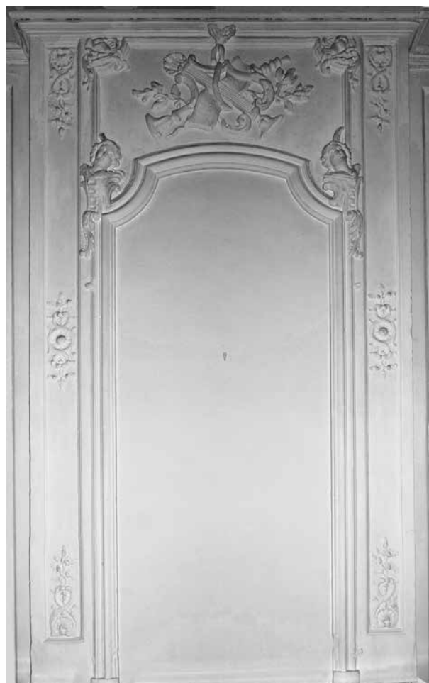
Fig. 10. - Salle du rez-de-chaussée, trumeau.
