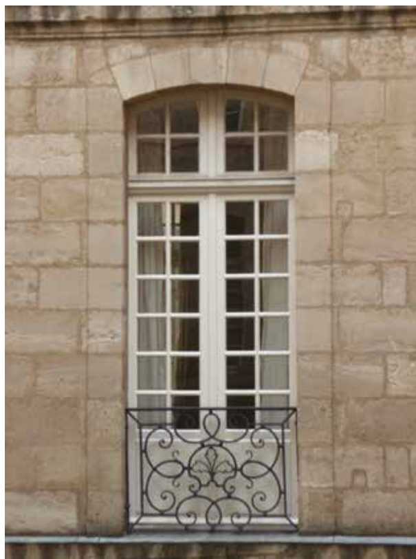
Fig. 6. - Cour intérieure, balconnet.
