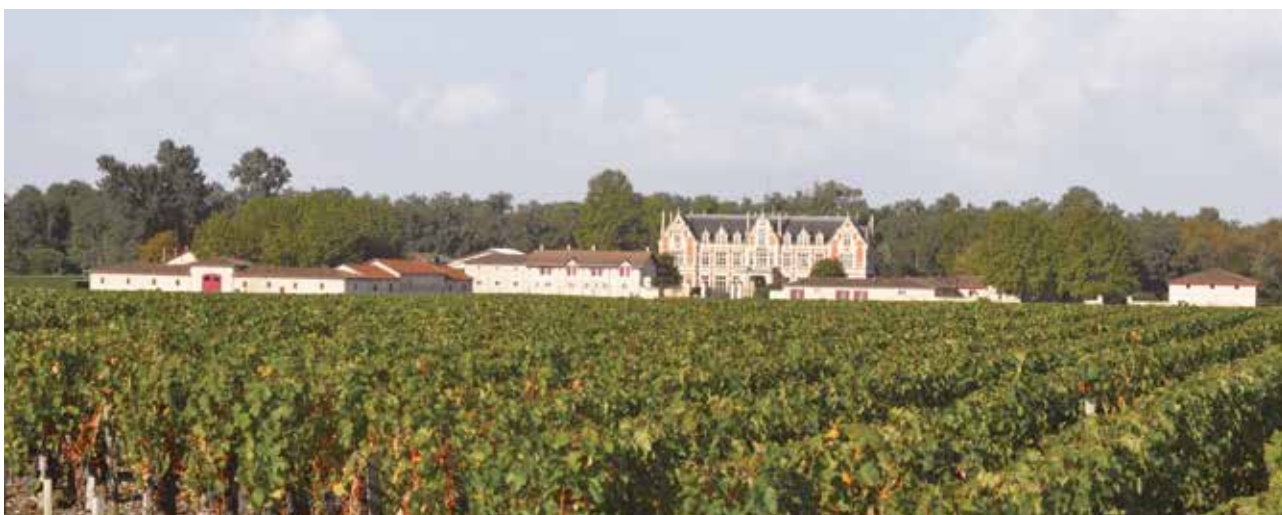
Fig. 8. - Château de Cantenac-Brown : vue d'ensemble depuis l'est. © Région Aquitaine, Alain Beschi, Inventaire général, 2010.
