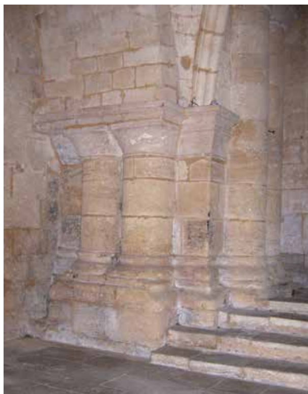
Fig. 12. - Pilier d'angle intérieur de l'église collégiale de Saint-Émilion présentant une paire de colonnes engagées. Cliché N. Sauvatre, Hadès, 2011.
