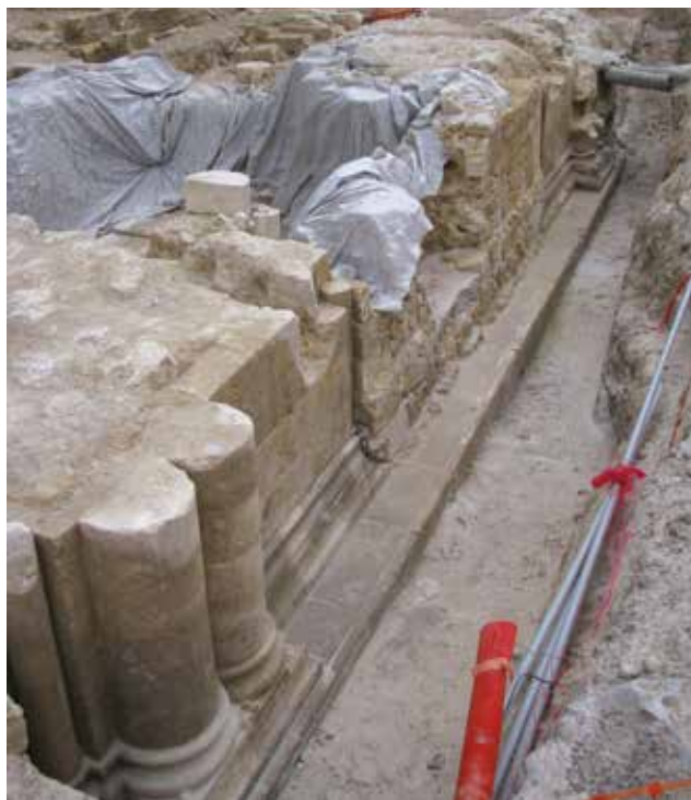
Fig. 3. - Vue du soubassement nord du porche. Cliché N. Sauvaitre, Hadès, 2009.
