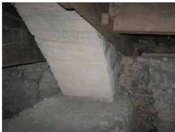
Fig. 15. - Détail du départ de l'arc-boutant séparant la première et la deuxième travée du bas-côté, vu dans les combles. G.A, septembre 2011.
