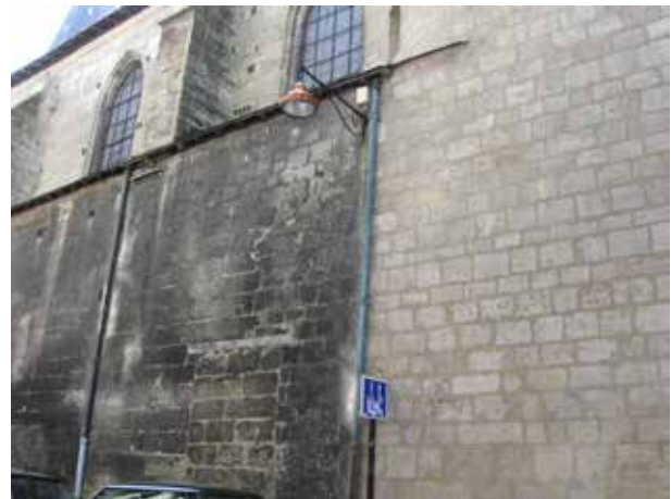
Fig. 2. - Façade Nord. Détail de la continuité d'appareil entre la Grosse Cloche et le mur gouttereau de l'église. G. A, avril 2010.
