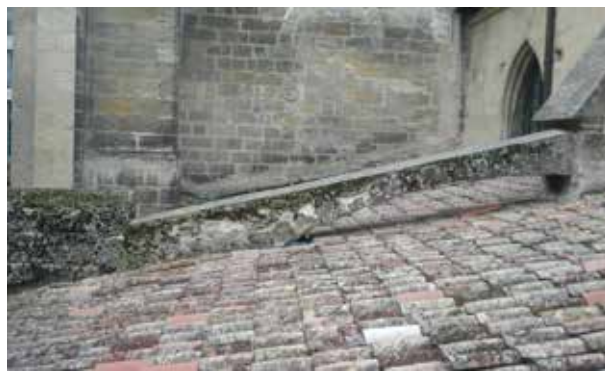
Fig. 14. - Arc-boutant séparant la première et la deuxième travée du bas-côté. G.A, octobre 2011.
