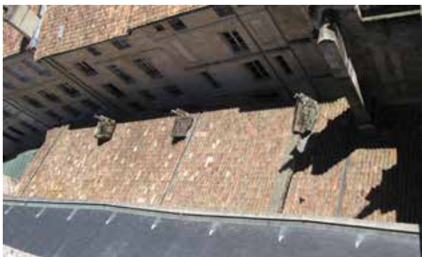
Fig. 13. Bas-côté, vue d'ensemble de la toiture prise depuis la Grosse Cloche. G.A, juillet 2010.
