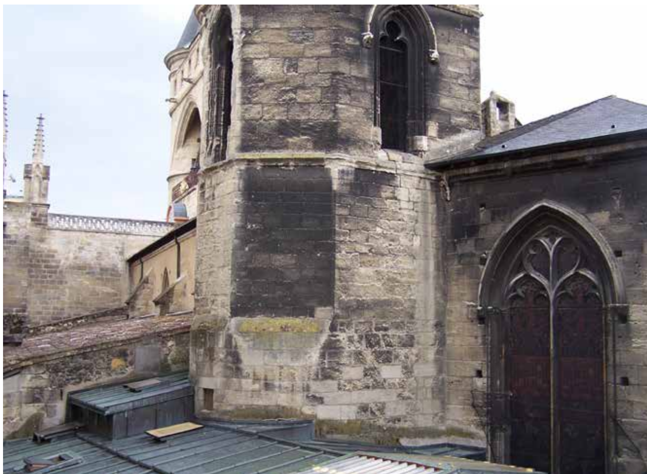
Fig. 9. - Sommet de la tour de courtine (plan circulaire) et clocher (polygonal). G.A, février 2011. La séparation entre les deux structures est marquée par un glacis.
