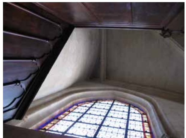
Fig. 8. -Baie Nord de la première travée de la Nef, mitoyenne de la tour Est de la Grosse Cloche. G. A, mai 2010.
