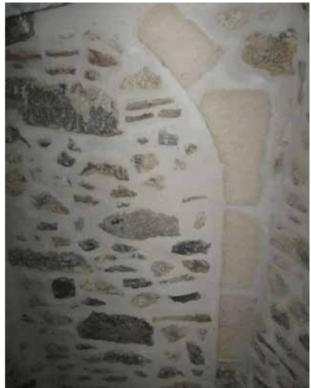
Fig. 11. - Trace d'un encadrement de baie dans la maçonnerie des murs de l'escalier en vis menant au clocher. G.A, mai 2010.
