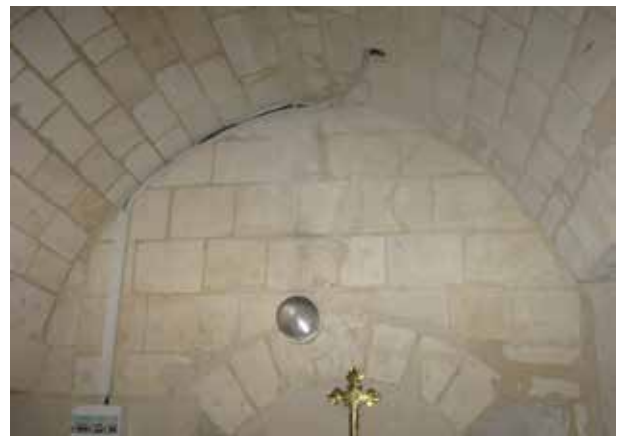
Fig. 7. Mur Nord (4003) de la salle voûtée en cul-de-four, au rez-de-chaussée de la tour médiévale servant de base au clocher. G. A, mai 2010.
