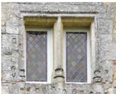
Fig. 19a, 19b et 19c. - Fenêtres éclairant le premier étage du donjon : baies géminées ouvrant sur l'extérieur (à gauche et au milieu) et demi-croisée donnant sur la cour (à droite).
