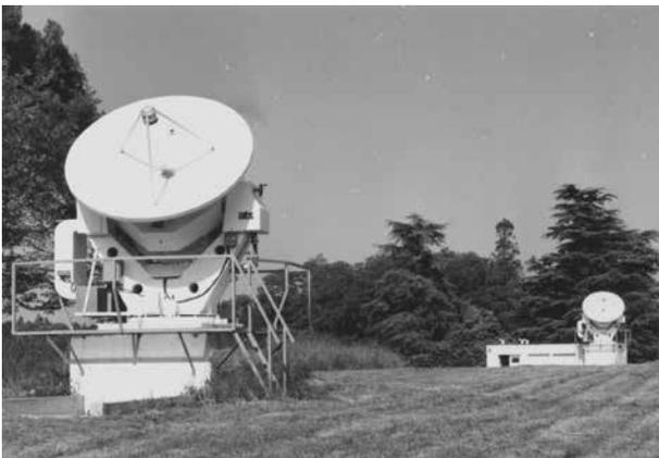
Fig. 23. - L'interféromètre à deux antennes de 2,50 m de diamètre, espacées dans la direction est-ouest de 66 m. Conçu dans les années 1970, il a été opérationnel en 1972 jusqu'en 1982. Archives de l'observatoire de Bordeaux.
