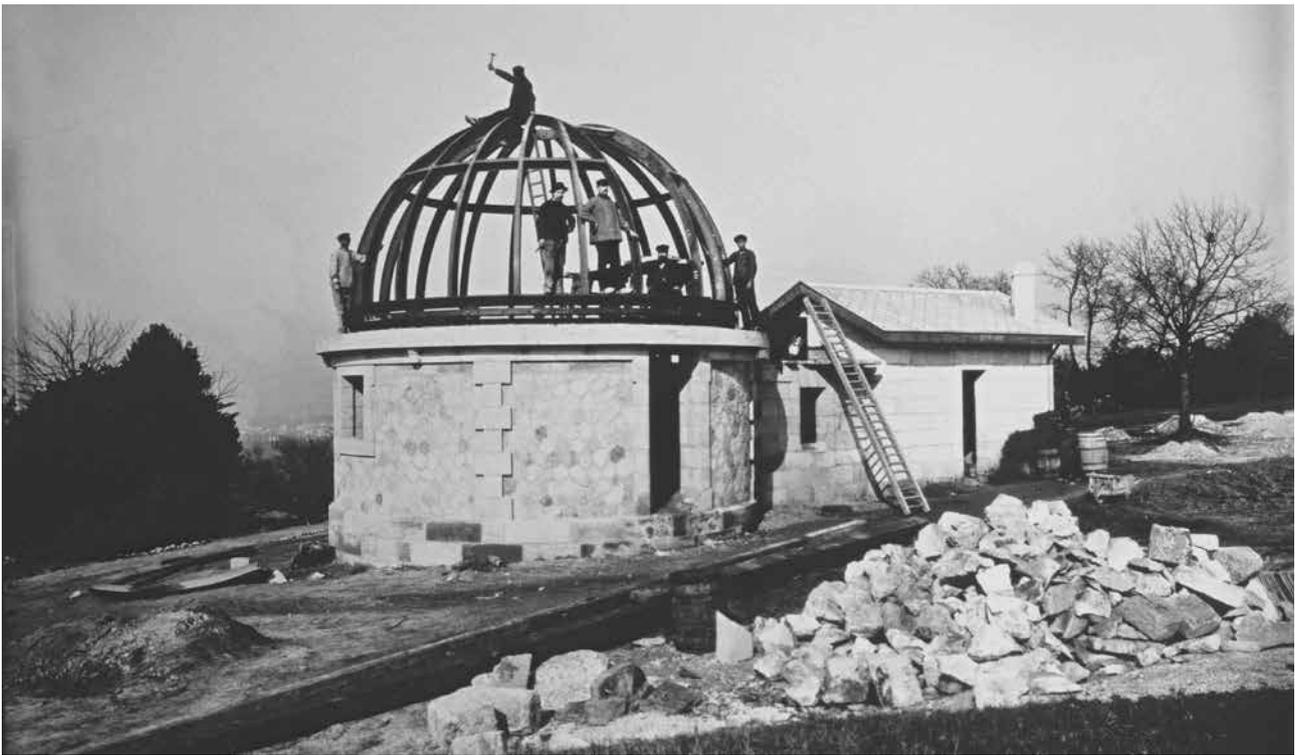
Fig. 10. - Construction du bâtiment et de la coupole de l'équatorial photographique en 1891. On distingue la coupole proprement dite, le laboratoire photographique et le bâtiment abritant la salle de mesure des clichés. *Région Aquitaine, Inventaire général - M. Dubau, [2004].*
