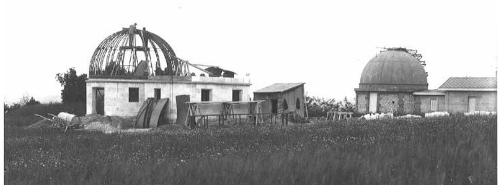
Fig. 19. - Au premier plan : construction du bâtiment et de la coupole de la table équatoriale dans les années 1940 ; au second plan : on voit la coupole de l'équatorial photographique et les bâtiments attenants. *Région Aquitaine, Inventaire général - M. Dubau, [2004].*
