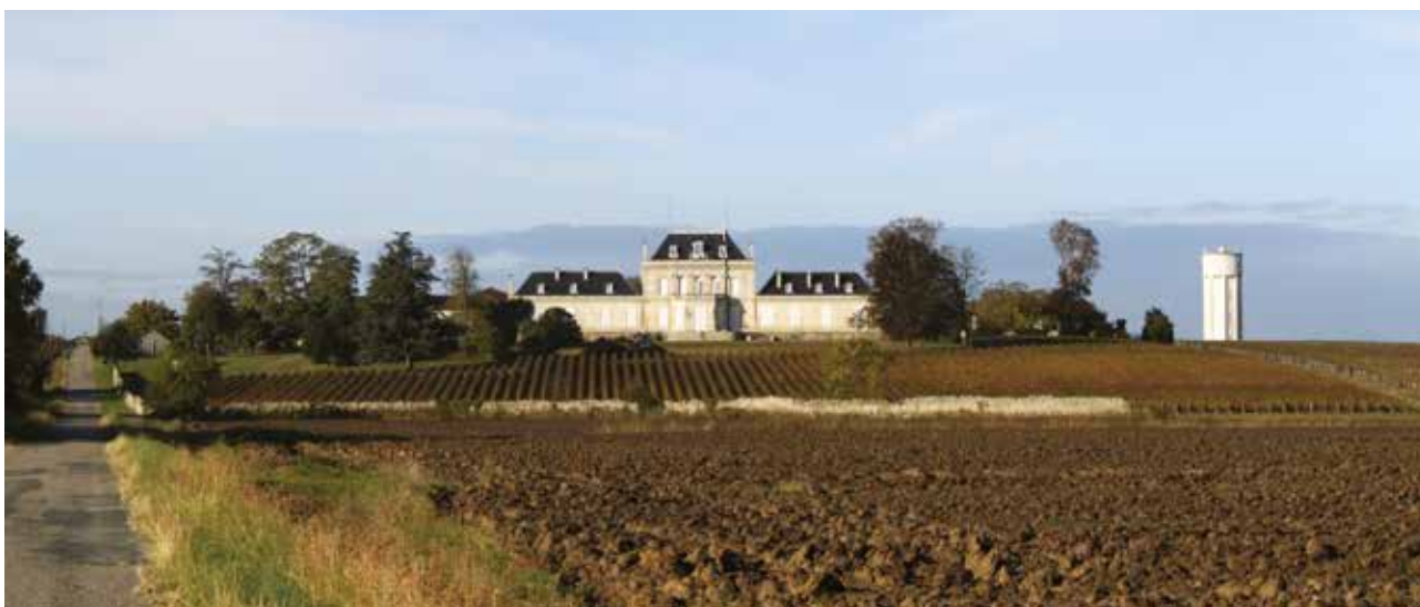
Fig. 1. - Le château du Boscq et le château d'eau à Saint-Estèphe (© C. Steimer, SRPI, Région Aquitaine).
