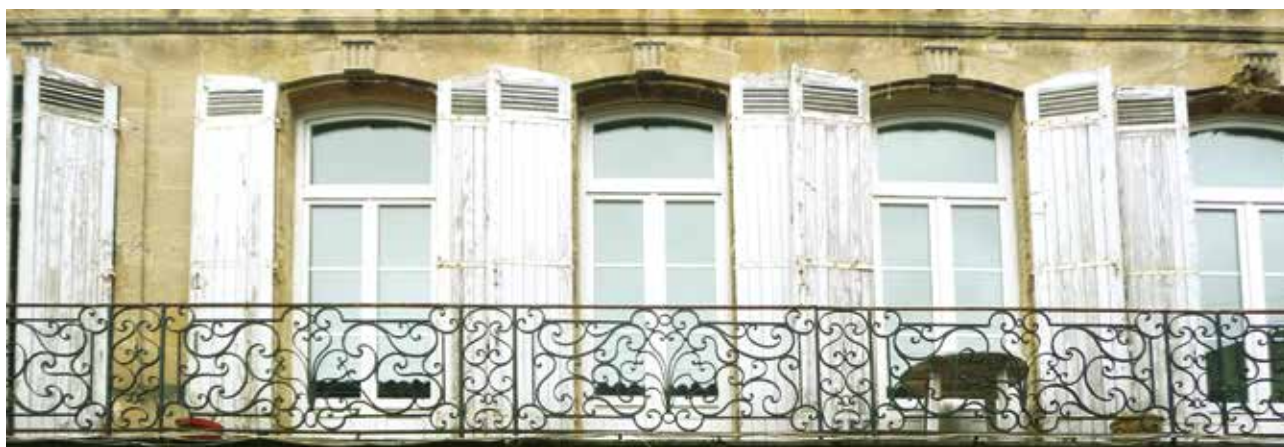
Fig. 5. - Balcon, vue générale.
