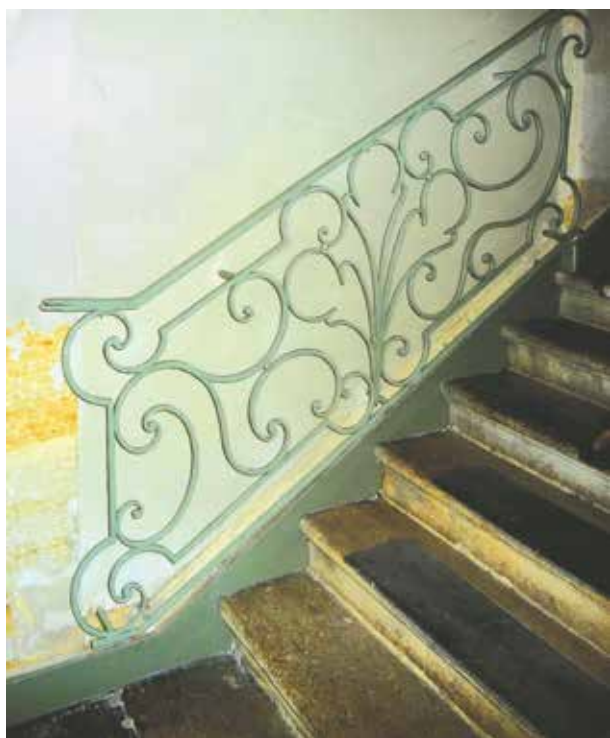
Fig. 7, 8, 9. - Cage d'escalier, éléments de ferronnerie.
