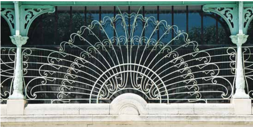
Fig. 8. - Grille de la façade principale du marché couvert, en 2008. Cl. Franck Delorme.
