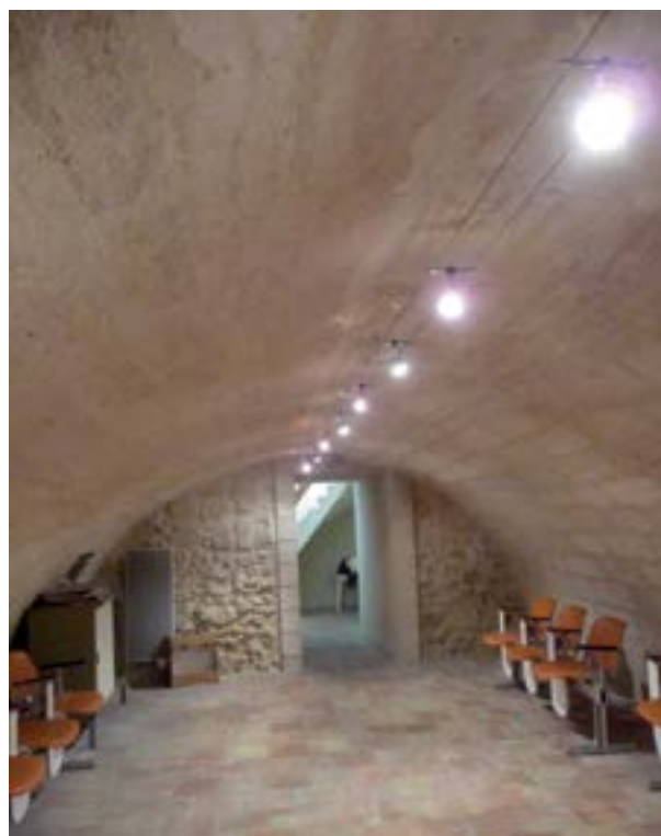
Fig. 22. - L'une des deux caves voûtées.
