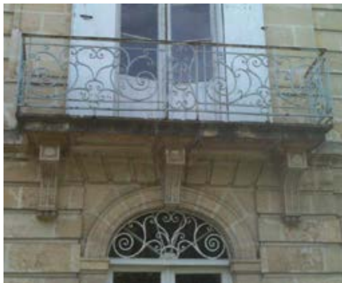
Fig. 19. - Balcon de ferronnerie
