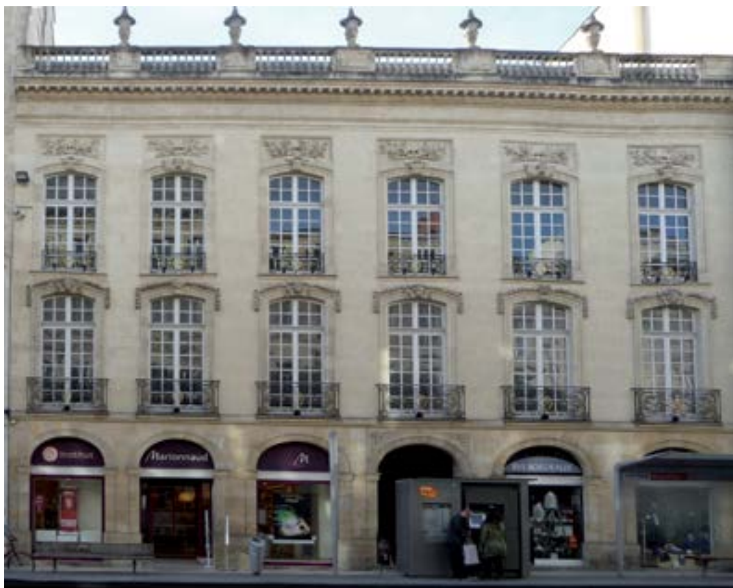
Fig. 1. - Façade de l'hôtel Lassalle cours de l'Intendance.
